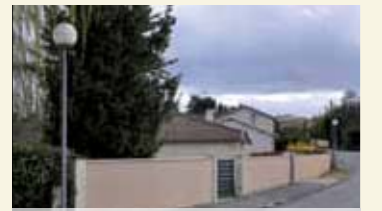
Remplacement des candélabres à boule
