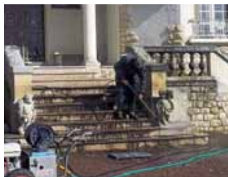
Un exemple de chantier assuré par 3S
