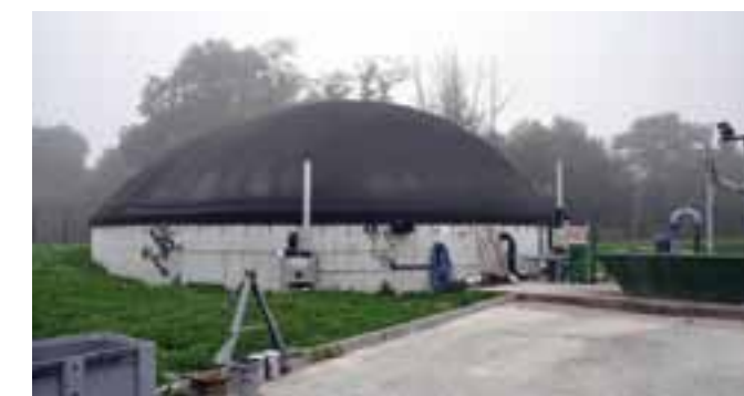
Les matières utilisées pour le méthaniseur sont très variées : lisier et fumier de canard, déchets d'abattoirs, graisses, restes de la cantine du lycée, mais aussi poussières de céréales, déchets verts de tonte et même invendus de grandes surfaces (végétaux, pâtisseries).
