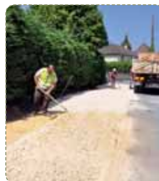
Des stationnements ont été créés avenue Foch
