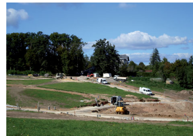
Eco-lotissement Bellevue, un chantier éco-responsable : tri et recyclage des matériaux, utilisation d'engins aux normes Euro 4...
