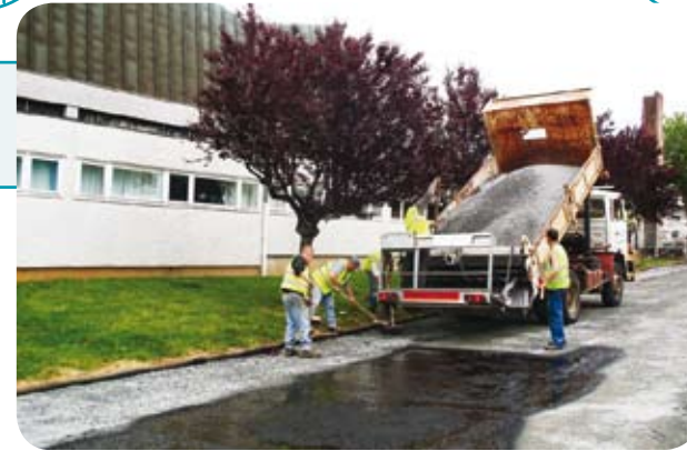
Travaux sur le parking de l'église de Chamiers.
