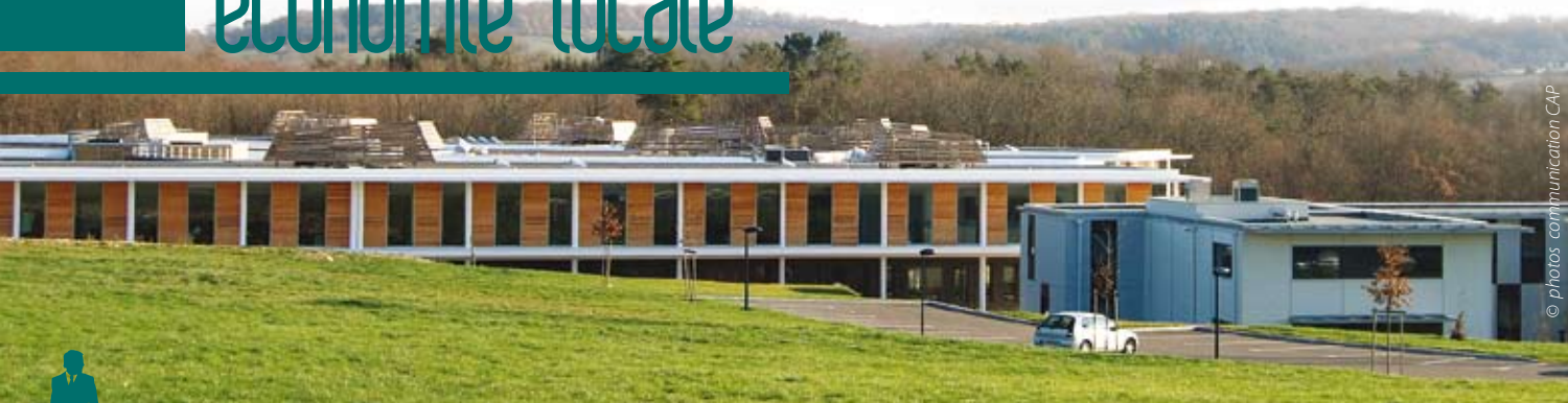
Le futur écopôle pourrait avoisiner le pôle interconsulaire et la pépinière d'entreprises à Cré@vallé Nord
